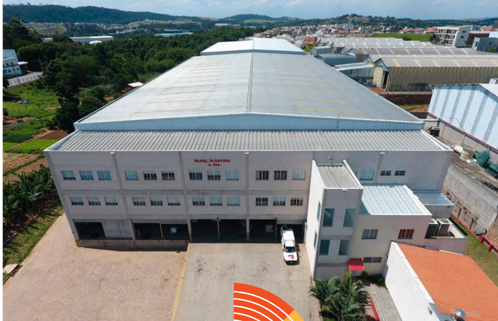
Centro de distribuição - Itupeva
